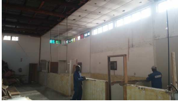
Hier is die meeste van die droë muur partisies afgebreek en die werkers besig om die steen gedeeltes af te breek.
