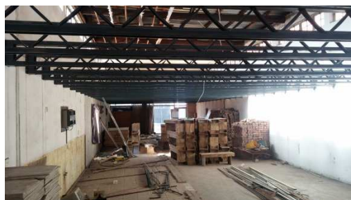
Eers die staalkonstruksie is in.....
